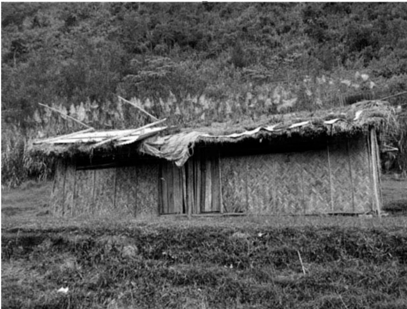
Figura 7. Escuela primaria de dos aulas con el piso de tierra (2001).
